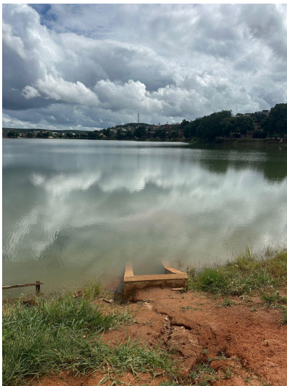
Final da Drenagem 1 (Desembocadura)
