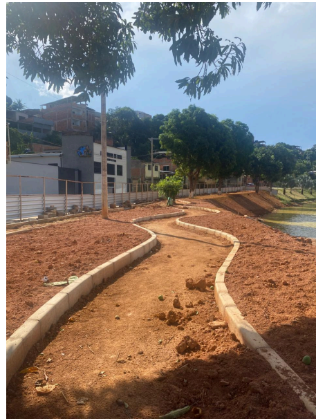
Passarela interligando as áreas 3 e 4 da Orla
