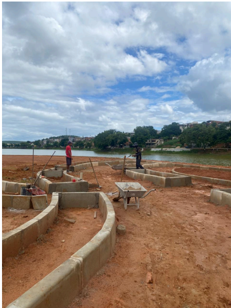
Passarelas construídas em cima do sistema de drenagem já finalizado
