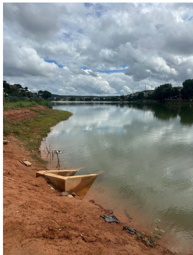
Final da Drenagem 3 (Desembocadura) Autoria: Thaís Calhau Data: 26/03/2026
